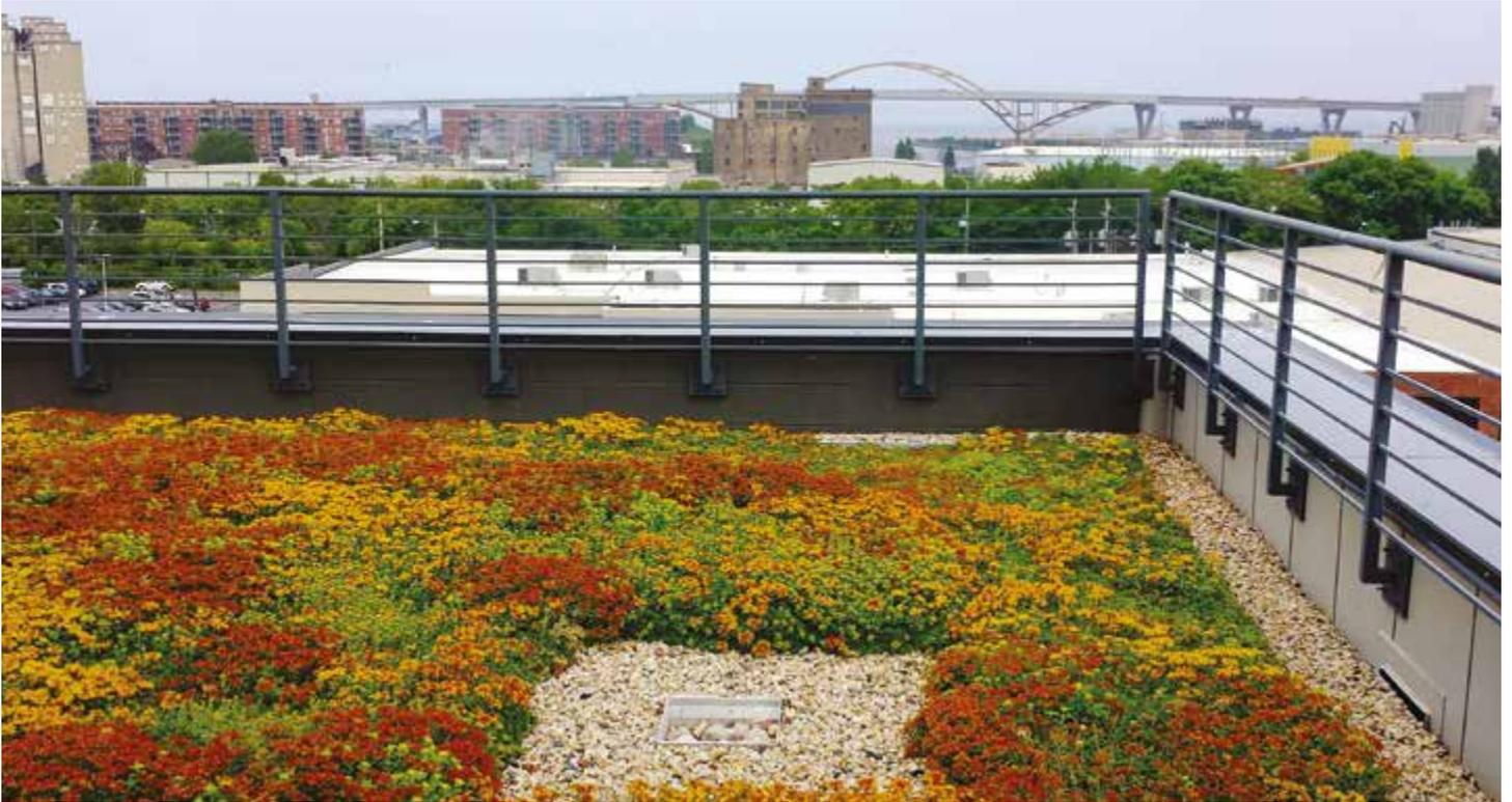
Eine typische Anwendung des erweiterten Dachgartens ist das begrünte Dach, das gemeinhin mit Pflanzen wie Fetthennen oder ähnlichen Sorten umgesetzt wird, die nicht gepflegt oder mit Wasser versorgt werden müssen. Diese Pflanzen benötigen ein Substrat mit geringer Dichte: Das Paket ist also leicht und kann auf allen bestehenden Dächern angebracht werden, egal ob sie flach oder geneigt sind.
